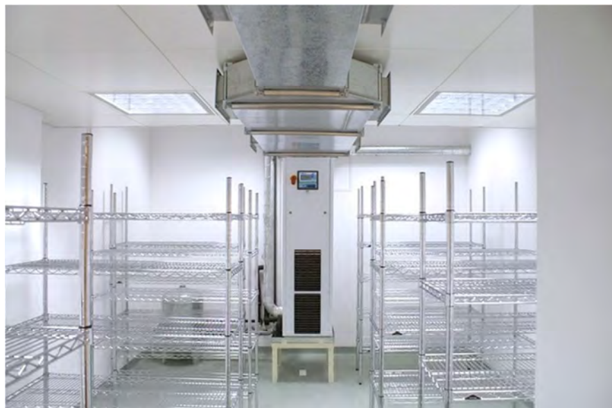
Instalacja klimatyzacji precyzyjnej wykonana w fabryce leków przez FRIGO Sp. z o.o.
